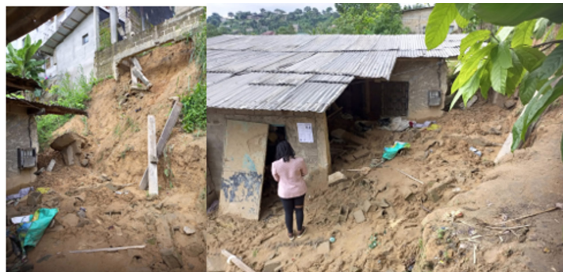
Planche photographique 1 : Glissement de terrain à Ndogbong
